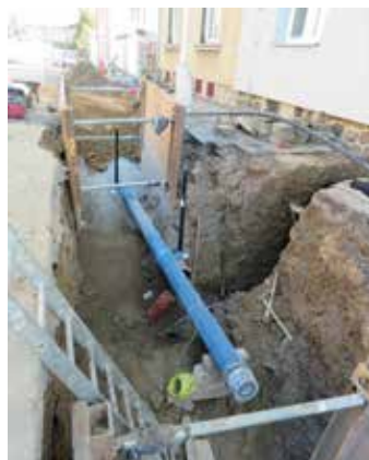
Výměna vodovodu ve Štítné ulici v Táboře.
